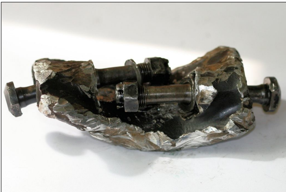
Obr. 3 – Detail zdeformovaného víka hlavy ojnice č.6 a šrouby ojnice s maticemi bez závlaček.
