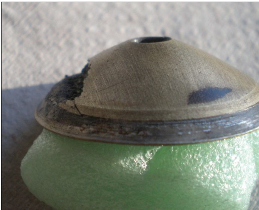
Obr. 7 – Zátka ze 6. ojničního čepu, pohled 1. Významné zeslabení vnitřní stěny zátek korozí.
